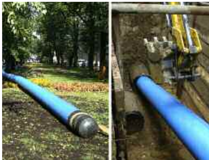
2010 г., Москва, Б.Филевская улица, Ø 400 мм, восстановление стального водопровода 450 мм
