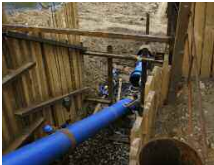
Черкизовский пруд, Ø 630 мм, напорная канализация
