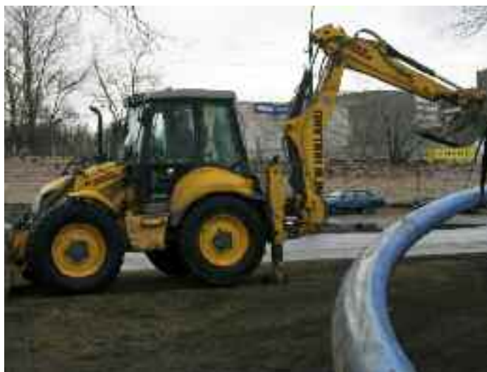
Прокладка водопровода методом ГНБ, Жилой комплекс по адресу: Бестужевская 7 СПб. СК Аркада, 2011 г.
