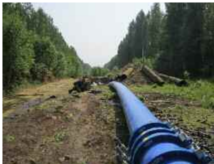
Реконструкция магистрального водовода в г. Кировград, филиал ППМ ОАО «Уралэлектромедь», Ø 500 мм, 2012 г.
