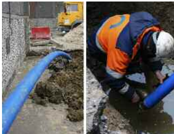
Водоканал СПб, прокладка внутриквартального водопровода, Пулковское шоссе д. 16, Ø 110 мм, 2011 г.
