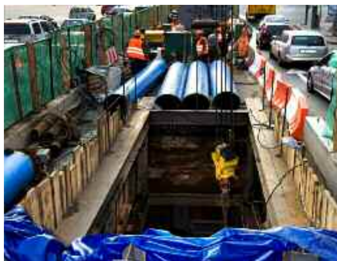
г. Москва, Садовое кольцо, реконструкция водопровода, сети Мосводоканал Ø 630 мм, 2012 г.
