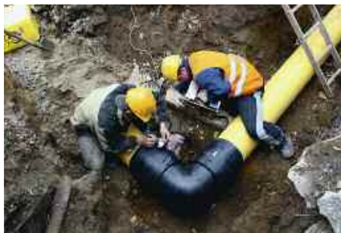
Рис. 14. Сварка муфтами с закладными электронагревателями в процессе монтажа трубопровода
