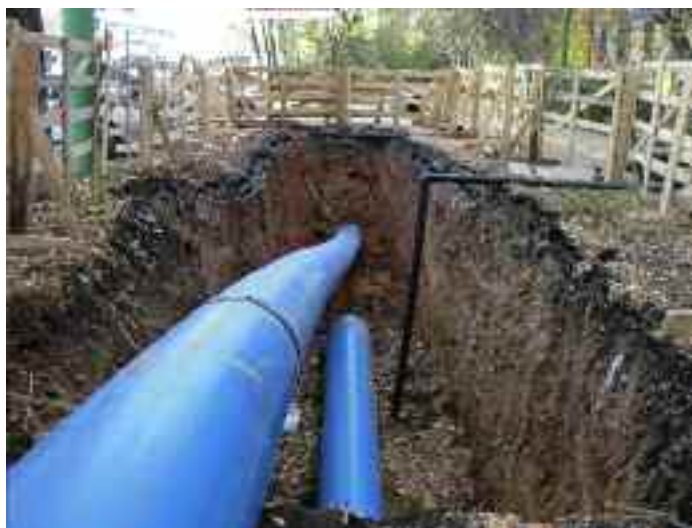
2010 г., Ø 630 мм, замена чугунного водопровода, протяженность участка – 1121 метр, работы проводила компания ООО «Аверс-СК» по заказу METRO Cash and Carry
