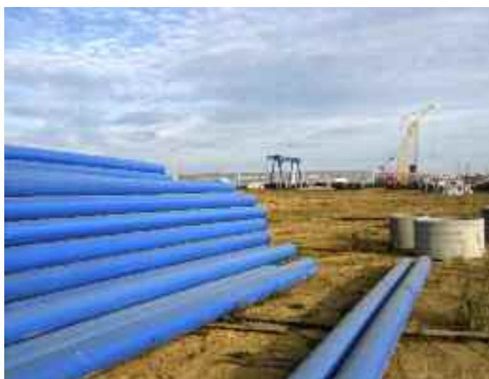
Строительство сетей НВК на Богучанском алюминиевом заводе
